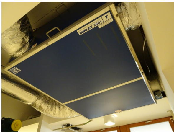
Vzduchotechnická jednotka pro větrání prádelny a sušárny.
