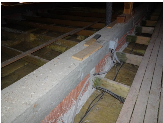
Nevytápěný půdní prostor budovy „A“. Detail tepelného mostu procházející stěny skrz tepelnou izolaci, stěna není nijak zaizolována.
