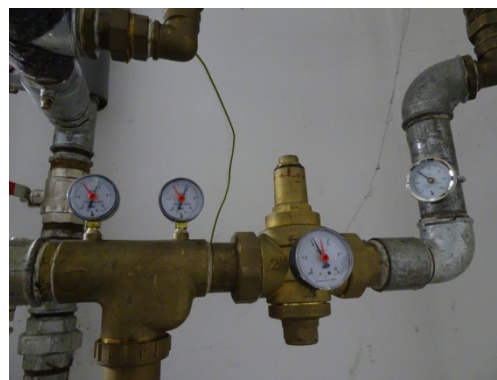
Nastavení tlaků v rozvodech vody na 4bar.
