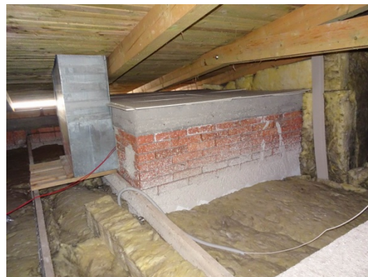
Nevytápěný půdní prostor budovy „A“. Detail tepelného mostu procházející dojezdové šachty výtahu tepelnou izolaci stropu, šachta je vyzděna z dutinových cihel, není nijak izolována.
