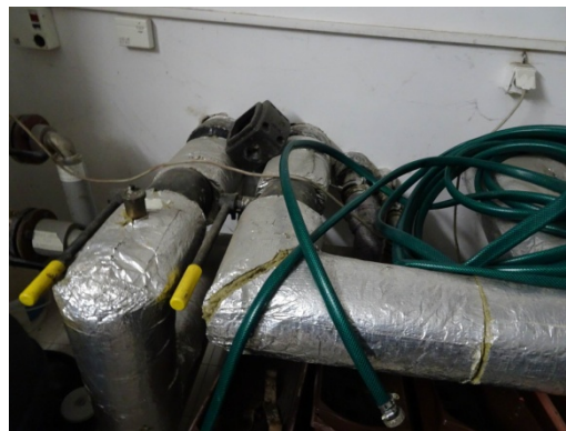
Hlavní přívod tepla a teplé vody do budovy, 4 trubky. Předávací výměník je přes ulici v protější budově cca.36m vzdálený.
