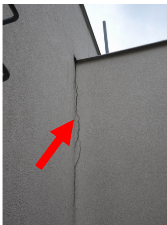
Prasklina ve fasádě, napojení schodiště na budovu „C“, prasklina způsobena dotvarováním konstrukce a dosedáváním základů.
