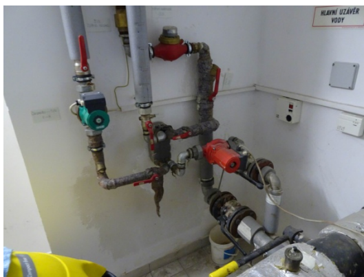
Měření spotřeby teplé vody a výměník s oběhovým čerpadlem na dohřev cirkulace (suterén budova „B“)
