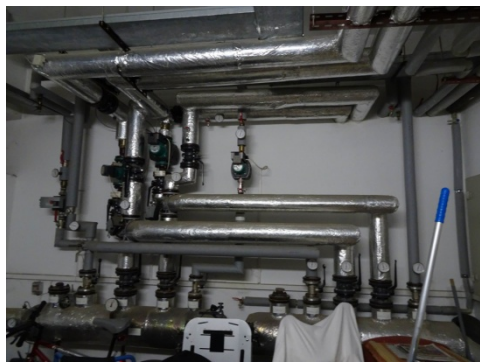
Pohled na hlavní rozdělovač a sběrač v budově. Otopné větve budova „A“, budova „B“, budova „C“ a okruh pro VZT jednotku
