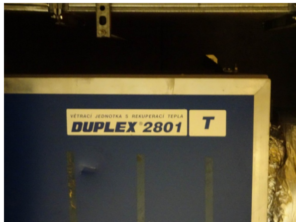
Vzduchotechnická jednotka pro větrání kuchyně a jídelny umístěná na chodbě v podhledu
