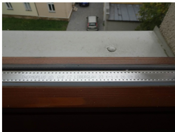
Distanční kovový rámeček izolační dvojskla typické pro celou budovu, U_g = 1,1 \text{ W/m}^2\text{K}
