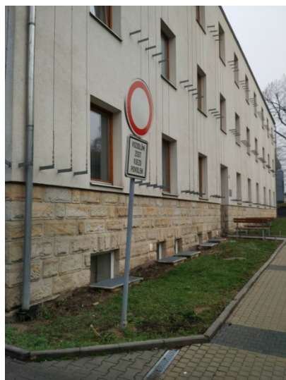
Budova „A“ – detail soklu budovu z pískovců
